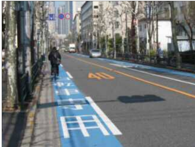
普通自転車専用通行帯（自転車レーン）
