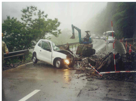
平成11年6月 落石発生 あがわ によどがわちよう (国道33号 高知県吾川郡仁淀川町)
