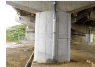
【国道8号新組跨線橋(新潟県長岡市)の上り線】
