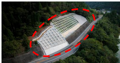
【防護コンクリートによる斜面崩落防止】
