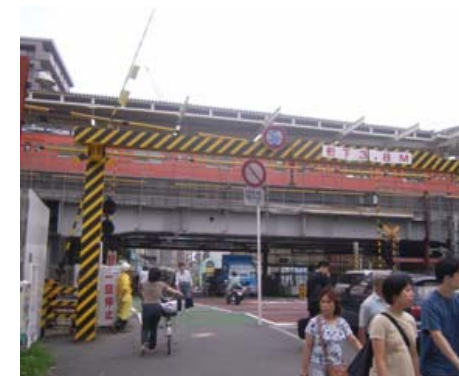
現在の状況(対策実施中)
