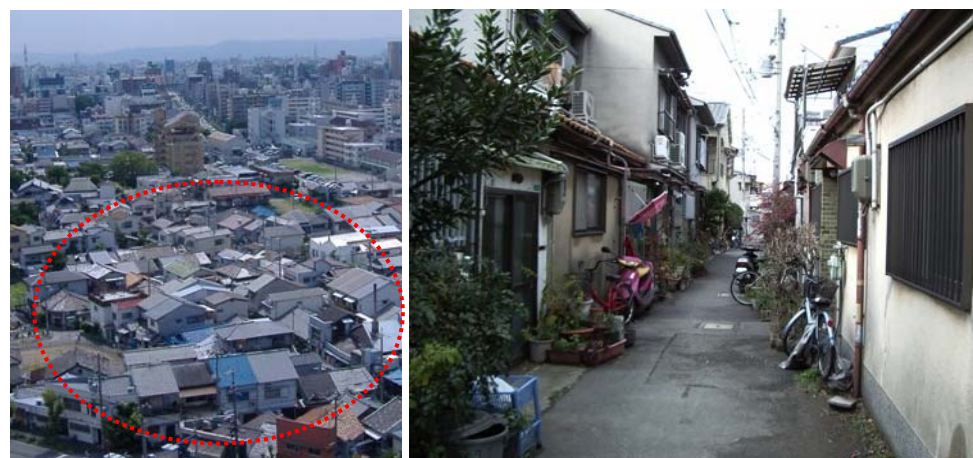
木造家屋の密集している状況 車両が入れない狭い地区内道路
