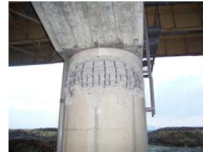
【国道8号新組跨線橋(新潟県長岡市)の下り線】
