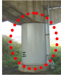
【鋼板巻き立て工法による橋脚の補強】
