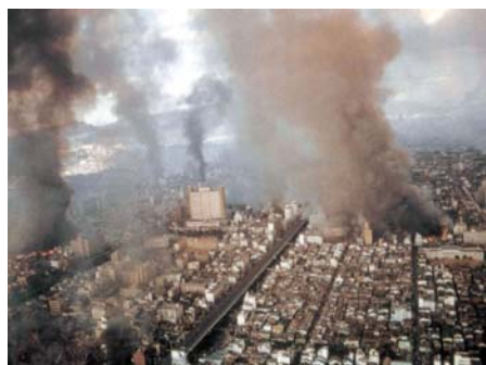
平成7年阪神・淡路大震災の状況 (「阪神・淡路大震災復興誌」より)
